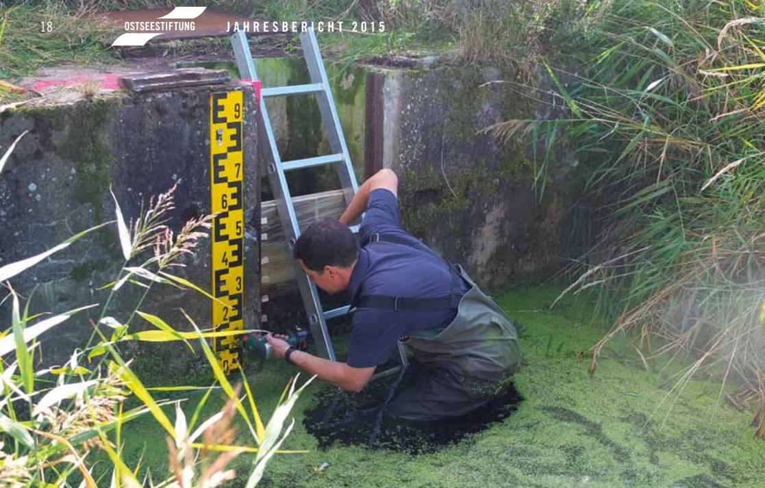
Grabenstau und Grundwasseranhebung; Rasmus Klöpfer befestigt die Messleiste am Wehr im Polder Drammendorf
