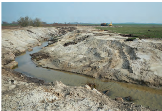
abschnittsweise verrohrte Piepenbeck an's Tageslicht geholt
