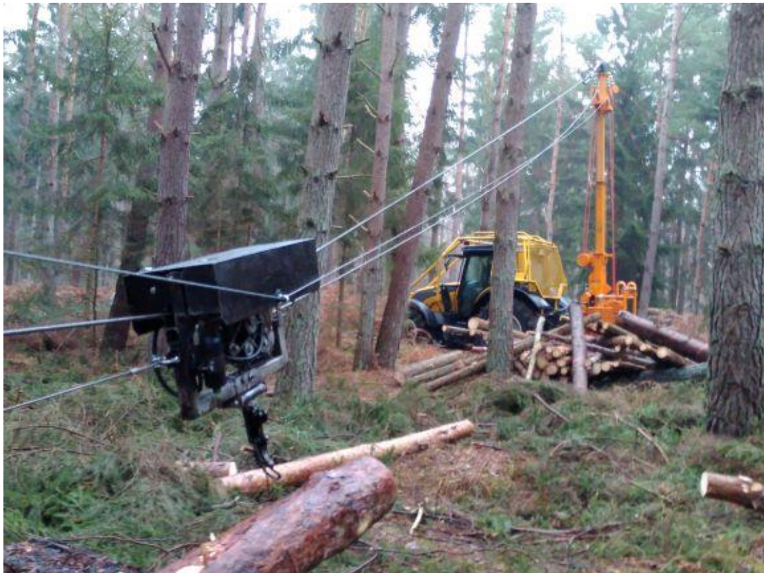
Abb. 22: Seilkrananlage in einem Fichten-Kiefern-Mischbestand in der Rostocker Heide. © Stadforstamt Rostock.
